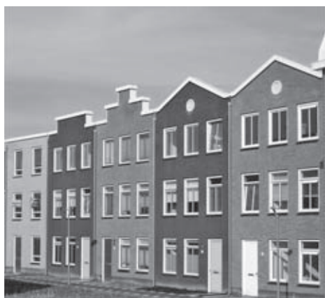
125 woningen en 77 appartementen Homeruskwartier, Almere
