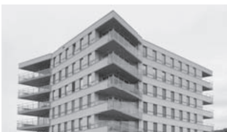
24 appartementen Westpoint, De Verwondering, Almere
