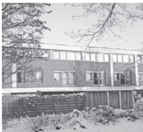
Renovatie 165 woningen Het lang Noord, Enschede
