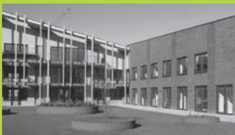
102 appartementen, kinderdagverblijf, parkeervoorziening, Terwijde, Utrecht.
