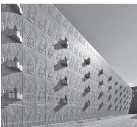
Parkeergarage Blok 11, Almere
